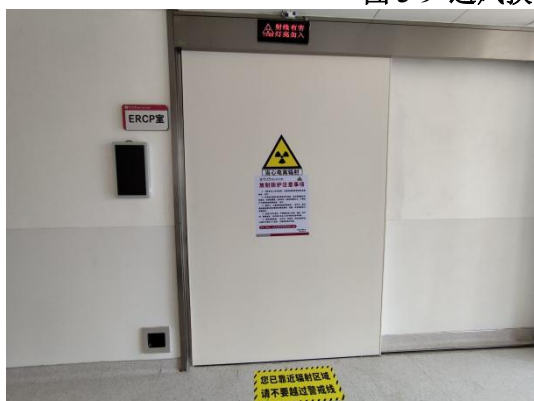
图 3-10 病人出入机房防护门
